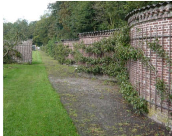
Abbildung 322 Klostersgarten: mit Bäumen an Mauern, um eine Fruchtwand zu erreichen oder/und wo Sorten angebaut werden konnten, die ein wärmeres (Mikro-)Klima brauchten
